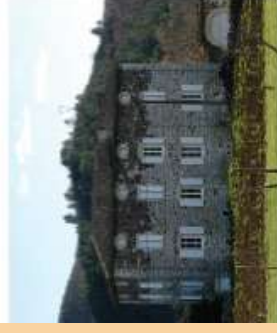
Demeure qui mixe les matériaux : basalte au dernier étage et calcaire pour les bas étages
