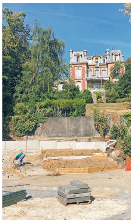
Travaux de la cour
