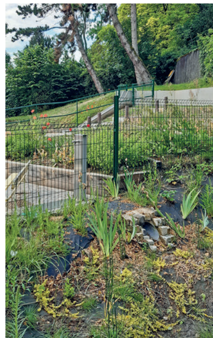
Un bassin d'infiltration récupère les eaux pluviales
